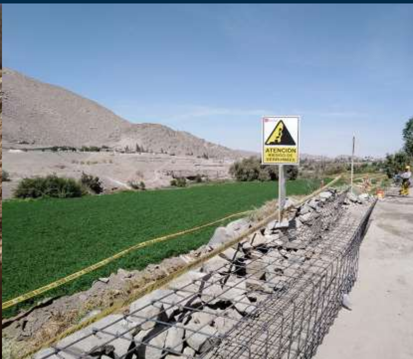
Obras hidráulicas / Carreteras / Canales de regadío
